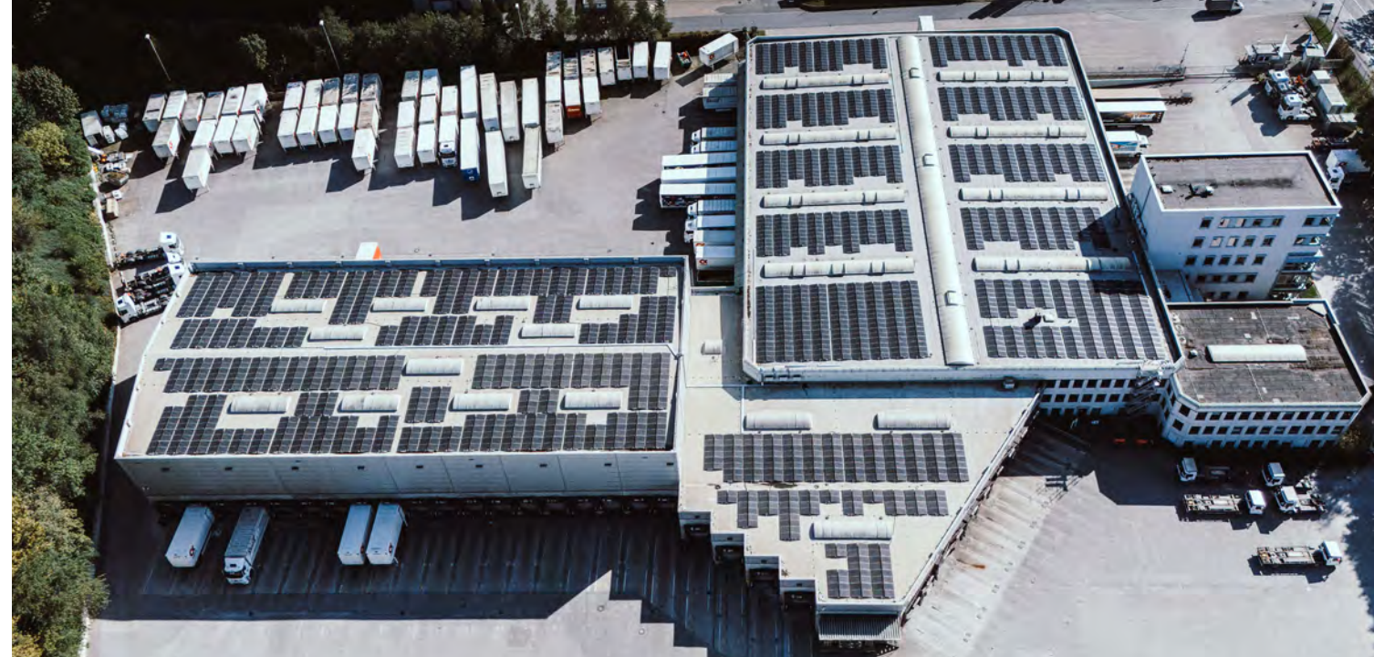
PV-Anlage am Standort Schwelm
